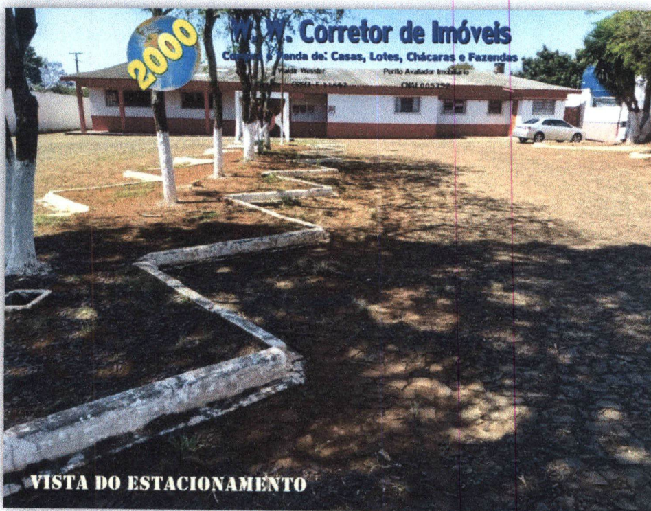
VISTA DO ESTACIONAMENTO
